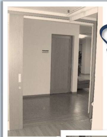
1階の居室入口
