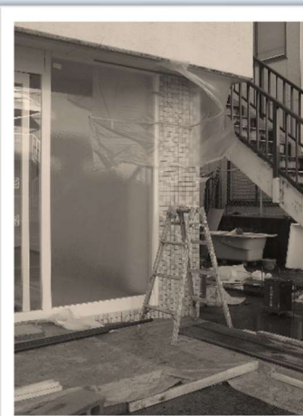
シオンの丘1階部分の改築。 玄関ホールや居室ができました。
